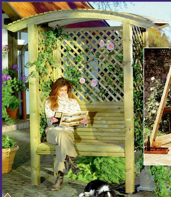
Садовая скамья-пергола. Четыре столба из бруса сечением 100х100 мм вместе с поперечными брусками образуют каркас перголы. Скамья сделана из строганных брусков сечением 50х50 мм.
