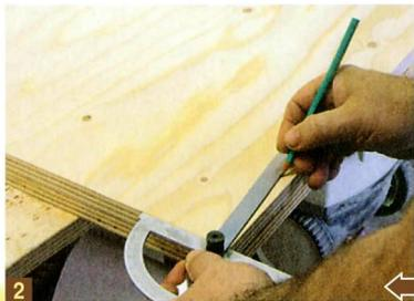
**2** Начинаем с изготовления боковин, которые будут одновременно ножками дивана. На листе фанеры размечаем две боковины и с помощью столярного транспортира размечаем скосы ножек.
