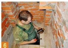
**1** Печь в подвале частично разобрана, выполняется новая футеровка огнеупорным кирпичом камеры для установки парогенератора. В левом нижнем углу камеры виден патрубок воздуховода.
